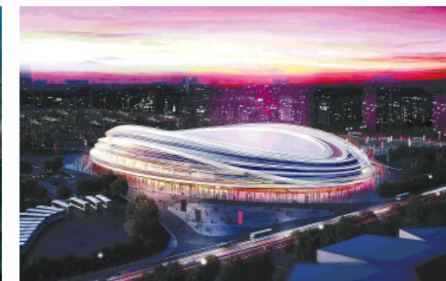
北京冬奥会高效节能配电项目
