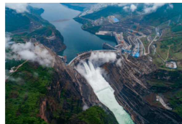
白鹤滩水电站特高压工程
